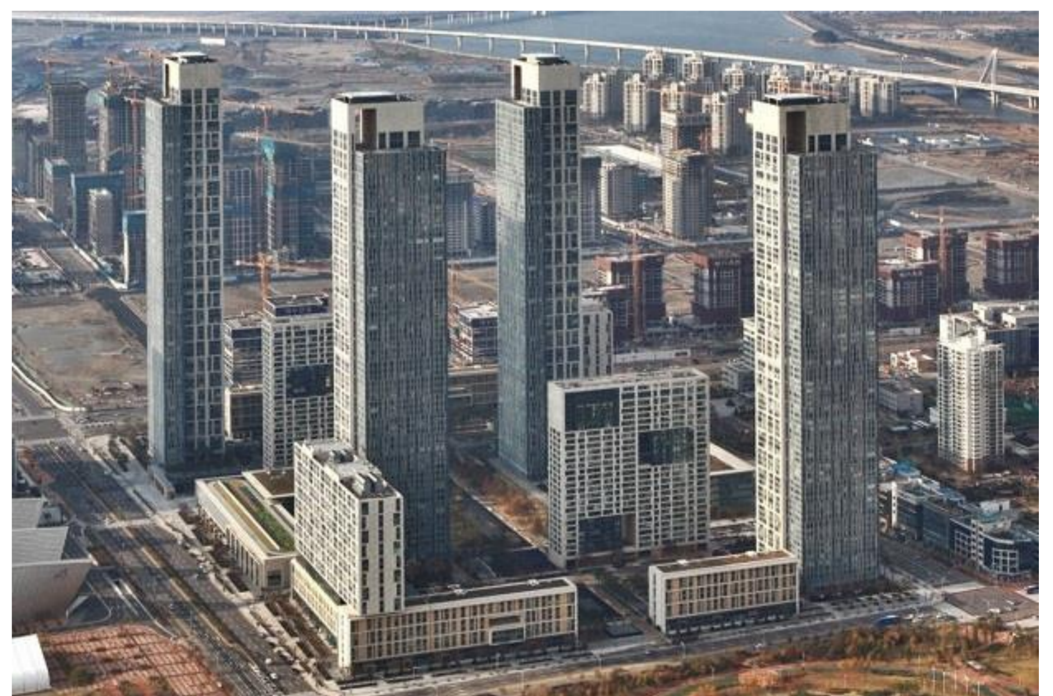
Abb. 2: Die untersuchten Hochhäuser des Gebäudekomplexes The #1 World , Incheon, Korea – POSCO Engineering & Construction Co. Ltd.
